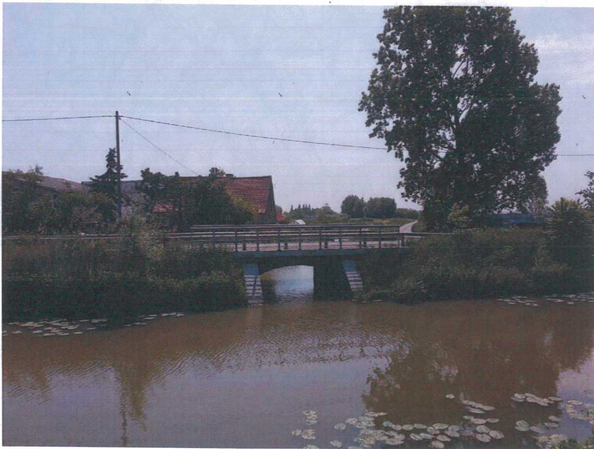
Vue du Canal de la Haute Colme vers le Deullaert
